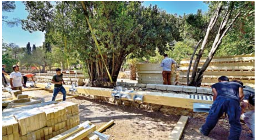
■ Komponenty věže byly s přesností na milimetry vyrobeny v Čechách a sestaveny na místě.
