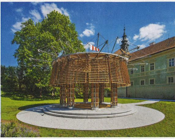
jsme přidali vrstvu pohyblivých panelů, které kryjí jak stavbu, tak i diváky před nepřízní počasí a zároveň nabízejí příležitosti moderovat vnitřní klima i atmosféru pavilonu; od vysokého a bohatě prosluněného až do stavu uzavřenosti a vydělení se v prostoru.
