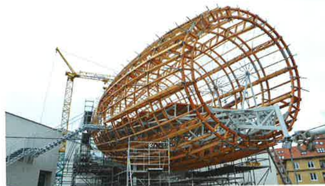
Základní nosná kostra ve střední části vzducholodě ukotvená k ocelové mostovce (foto Zbyněk Šrůtek)
