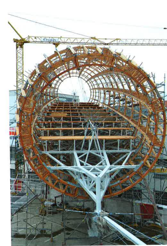
Pohled do tubusu střední části konstrukce (foto Zbyněk Šrůtek)
