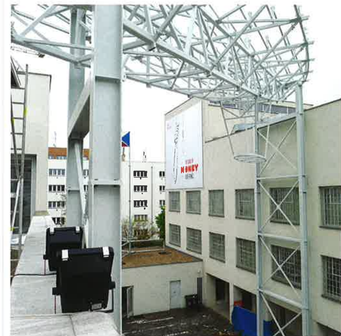
Osazená mostovka na ocelových bárkách (foto David Kubík)
