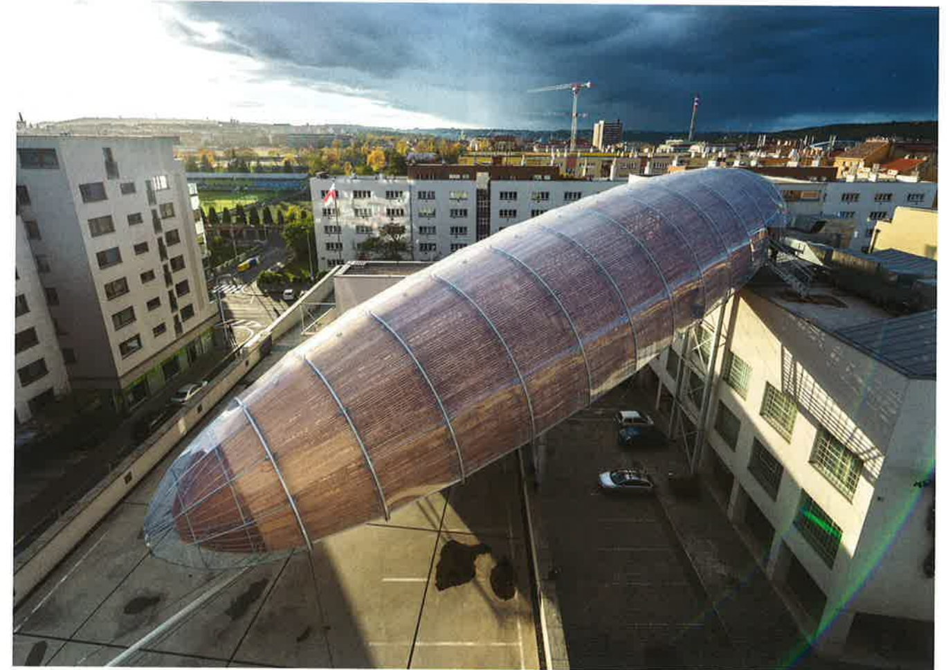
Pohled na konstrukci zastřešení vzducholodě z ETFE folie (foto Jan Slavík)
