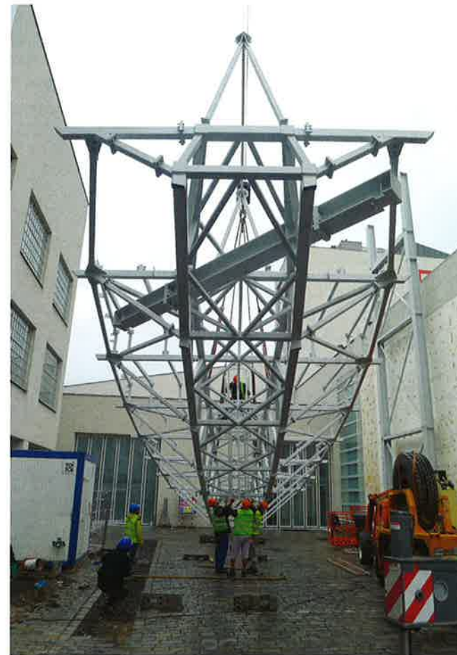
Sestavení ocelové mostovky na dvoře galerie DOX (foto David Kubík)
