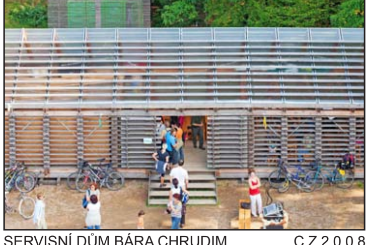
SERVISNÍ DŮM BARA CHRUDIM C Z 2 0 0 8
