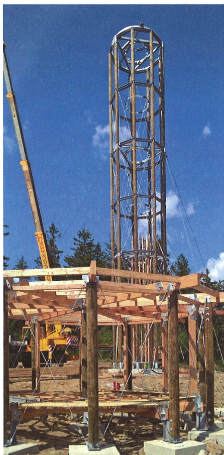
Obr. 7: Konstrukce přilehlého altánu
