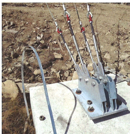
Obr. 4: Uchycení kotevních lan
