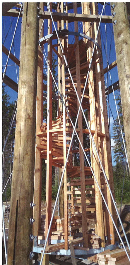
Obr. 8, 9: Montáž schodiště
