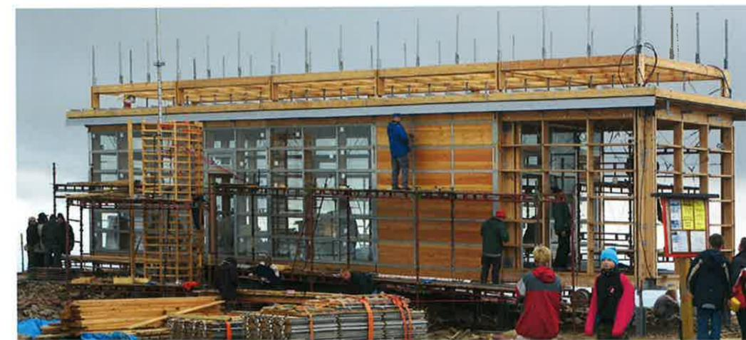
Completamento della struttura dell'involucro e realizzazione dell'elemento cilindrico che ospiterà la scala per poter salire sulla terrazza.
