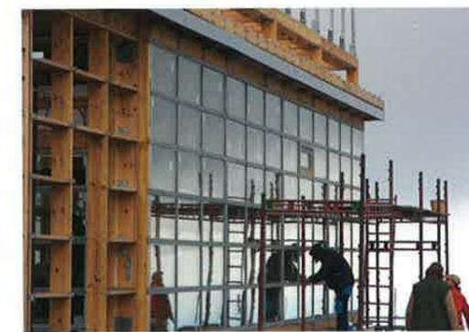
A sinistra, montaggio del sistema strutturale in legno: gli elementi verticali sono rialzati sopra una griglia metallica che li separa dal terreno.
