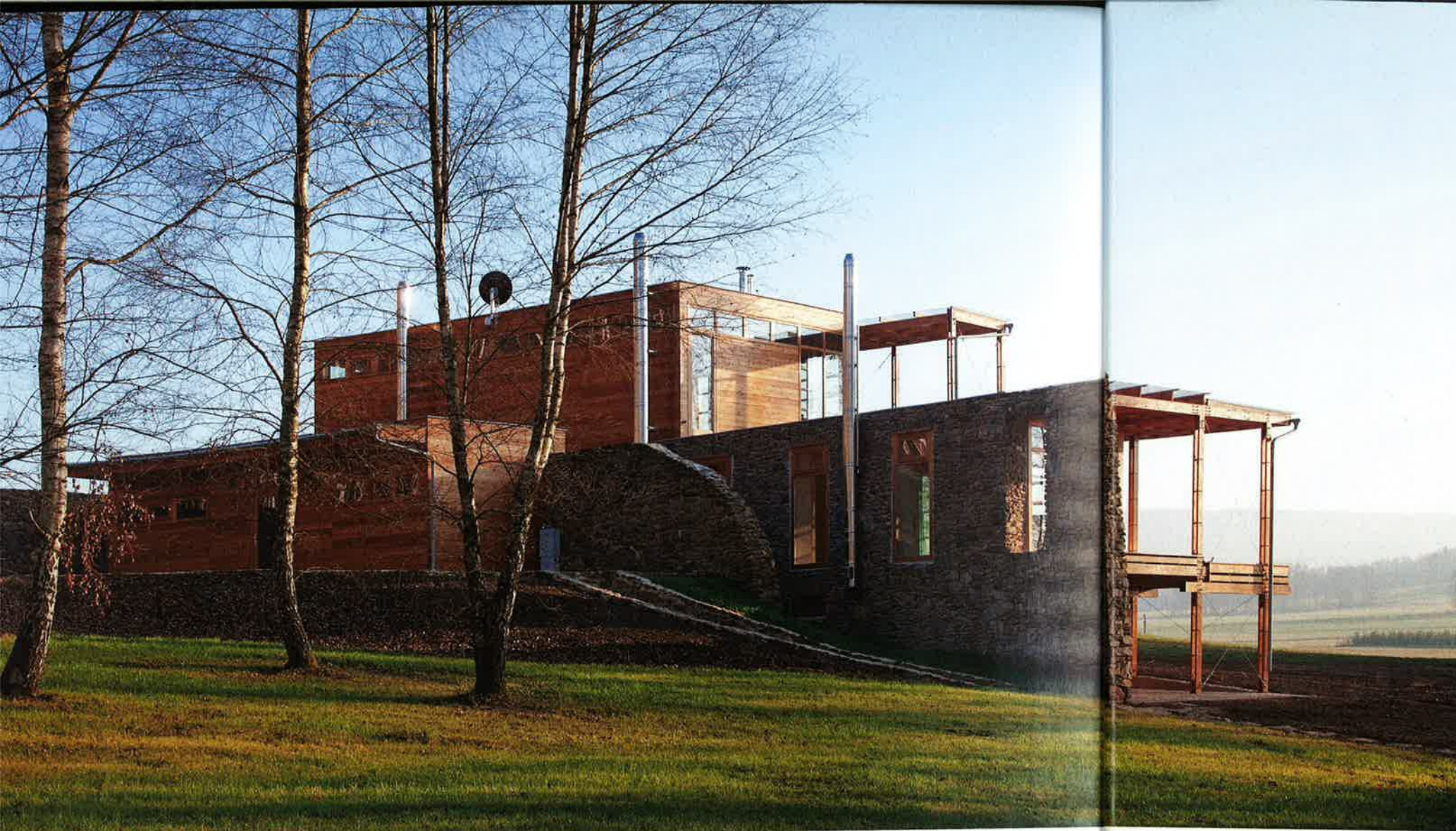
Těžká kamenná stěna orientovaná k severu se zakusuje hluboko do země, tvoří tak záda lehké dřevěné konstrukce.
