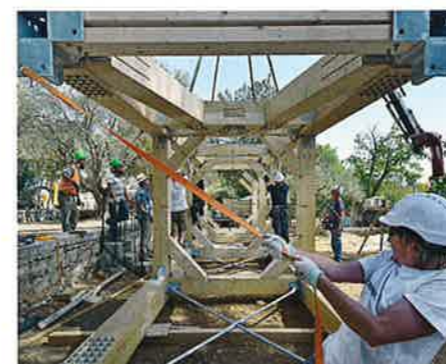
Vztyčování konstrukce
