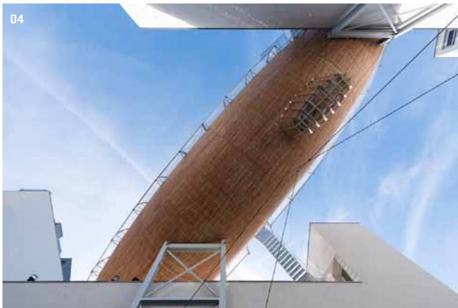
04 > Vzducholoď je orientována úhlopříčně nad budovami galerie. Mostovku podepírá dvojice ocelových příhradových sloupů-bárek, které vedou podél fasád uvnitř dvora
