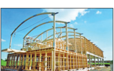
továrna koloděje C22004
