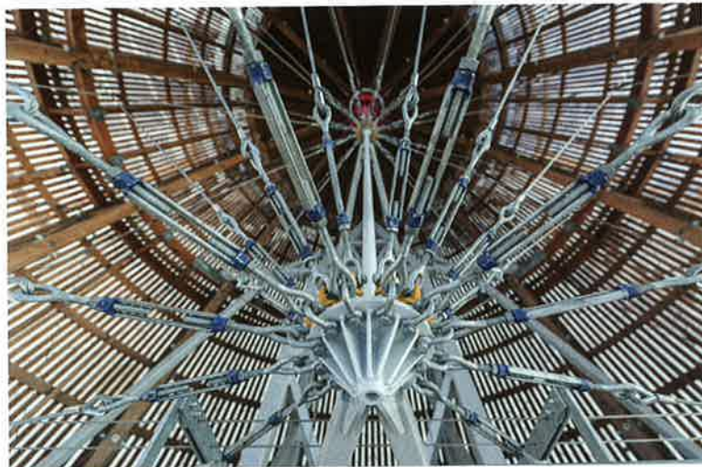
▲ Výztužný lanový systém v koncových částech vzducholodi (foto: Jan Slavík)
