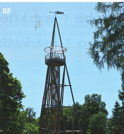
02 > Na stavbu bylo použito 20 m 3 modřínové tlakově impregnované kulatiny, 2,5 m 3 dubu pro schodiště a 3,3 t žárově zinkované oceli
